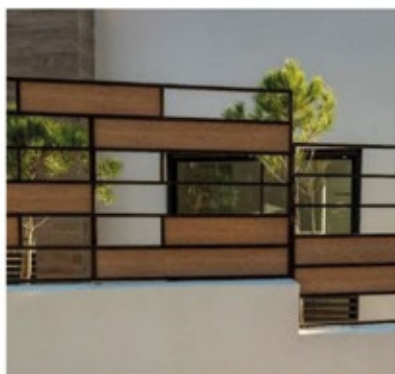
Cerramiento de parcela Muro + cerrajería + seto al exterior
